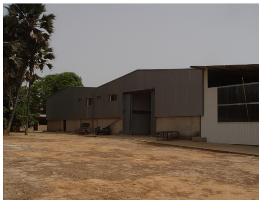
Figura 37: ARREY Fábrica de processamento de caju em Bula
