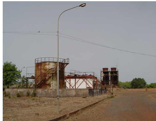
Figure 36: Instalações da Central de Bafatá
