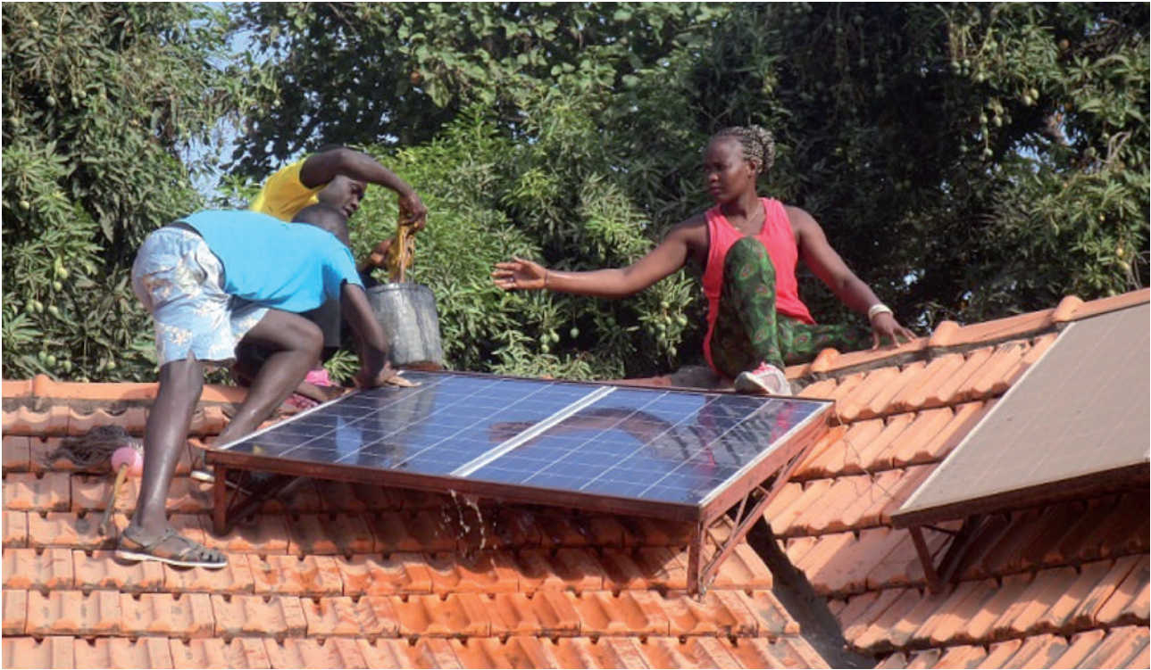
Figura 57 Componente prática do curso de energia solar FV na Escola Vocacional de Bissorã da ADPP-GB / Fonte: ADPP-GB, 2018 Figure 57 Practical component of the solar PV course in the ADPP-GB Vocational School of Bissorã / Source: ADPP-GB, 2018
