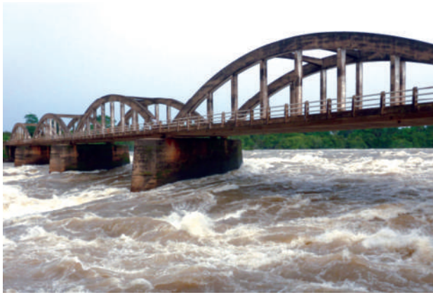
Figura 46 Ponte de Saltinho, época de chuva com caudal alto Fonte: PANER, 2017
