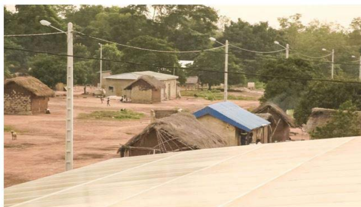
Figure 4 Mini-réseau PV en Côte d'Ivoire.
