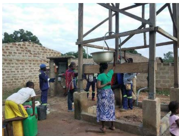
Figure 1 Pompage électrique et château d'eau communautaire
