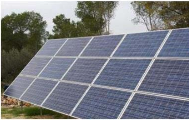
Figure 2 Structure fixée sur terrain SOURCE: Azimut 360
