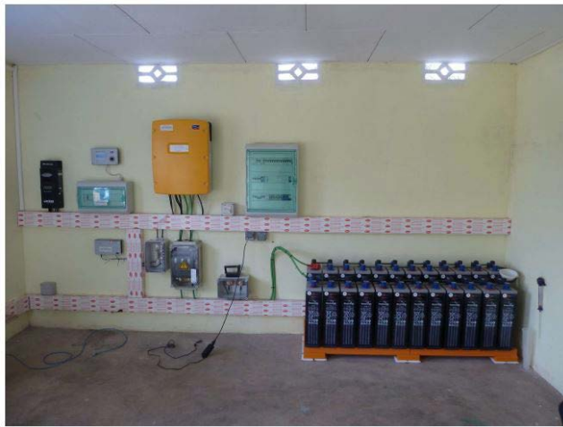
Figure 9 Exemple de système couplé en CC. SOURCE: Azimut 360
